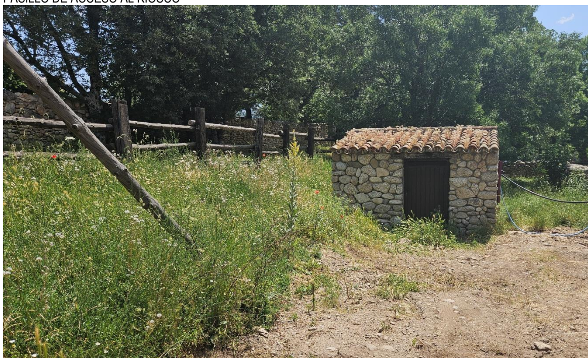
CASETA DE INSTALACIONES DE FONTANERIA
