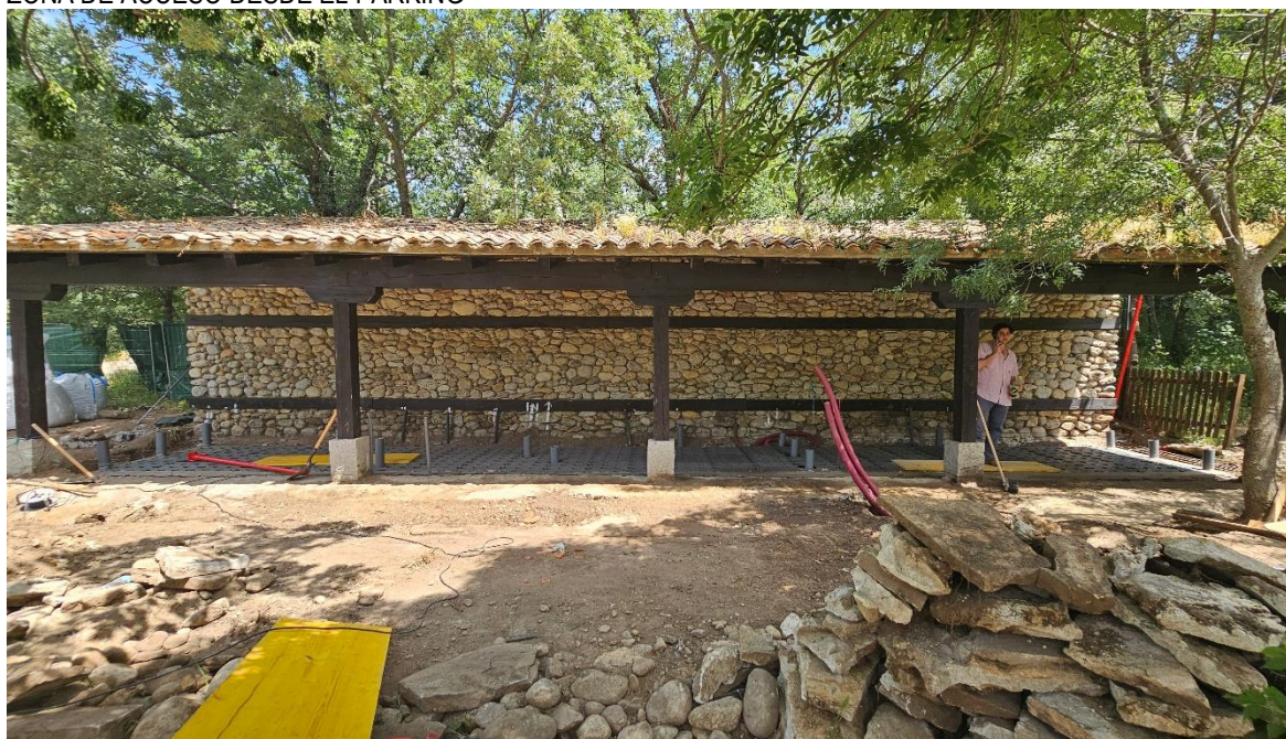
NUEVOS BAÑOS PUBLICOS EN EJECUCIÓN
